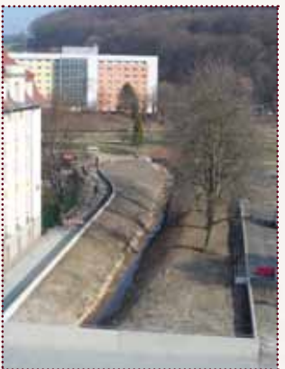
Offenlegung verrohrter Bachläufe und Entsiegelung ehemaliger Parkfläche zwischen Straße und Einmündung in die Weißeritz (Foto: Landschaftsarchitekturbüro Grohmann Dresden)
