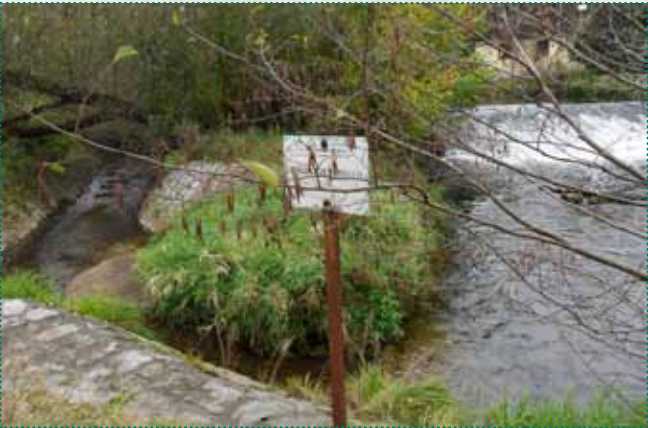
Seitliches Umgehungsgerinne an einer Wehranlage (Foto: LPV Sächsische Schweiz-Osterzgebirge e.V.)
