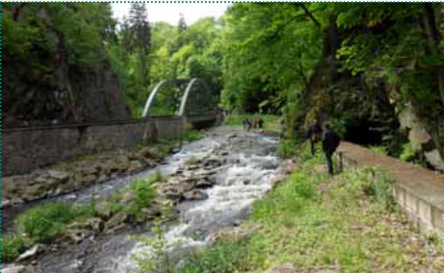
Verbesserung der Durchgängigkeit durch den Rückbau der Sohlschwelle und Gestaltung einer Rauen Rampe (Foto: LPV Sächsische Schweiz-Osterzgebirge e.V.)
