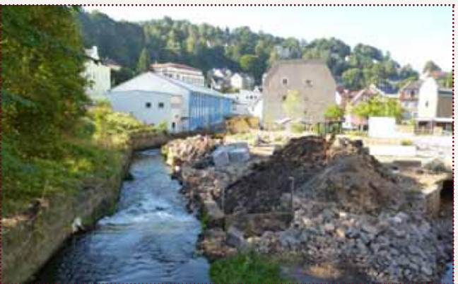
Während der Baumaßnahmen Quelle: Planungsgesellschaft Scholz + Lewis mbH Dresden, Steve Kobsch, Tel. 0351-2168345
