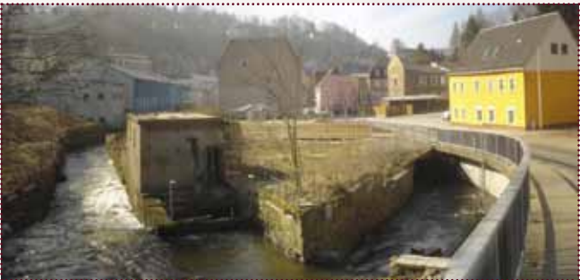
Wehranlage mit Wehrinsel nach dem Abbruch des Turbinenhauses und der Nebengebäude Quelle: Planungsgesellschaft Scholz + Lewis mbH Dresden, Steve Kobsch, Tel. 0351-2168345
