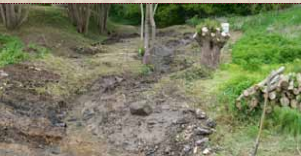
Beräumung der eingeschwemmten Sedimente und Neuprofilierung der Uferzonen Foto: LPV Sächsische Schweiz-Osterzgebirge e.V.
