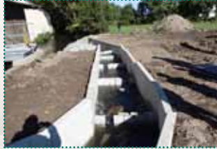
Umgehung der Anstauung an der Kleinen Röder mit einem Schlitzpass (Foto: Dr. Stefan Sieg)
