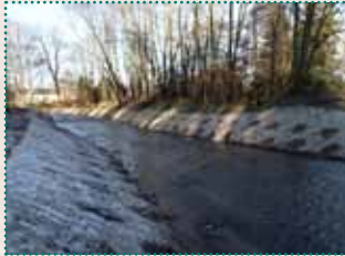
Rauhe Rampe nach Beendigung der Baumaßnahmen (Foto: Dr. Stefan Sieg)
