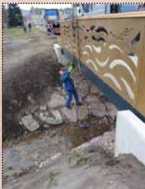
Die neue Brücke für Fußgänger und Radfahrer wurde 2014 gebaut. Quelle: Landschaftsarchitekturbüro Grohmann Dresden
