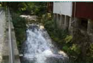
Wehrabsturz an der Felsenmühle, Kirmitschtal vor dem Umbau (Foto: Dr. Stefan Sieg)
