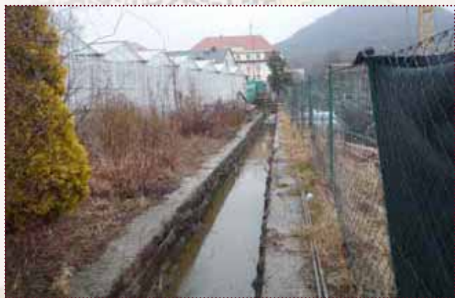
kanalisierter Verlauf zwischen Straße und Bahnlinie vor der Renaturierung (Foto: Landschaftsarchitekturbüro Grohmann Dresden)
