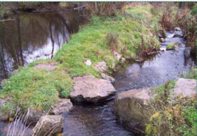
Naturnahe Laufgestaltung an einem Umgehungsgerinne (Foto: LPV Sächsische Schweiz-Osterzgebirge e.V.)
