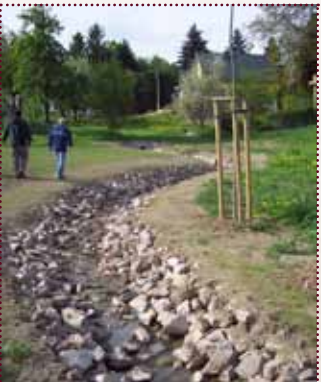
Offenlegung und Neugestaltung Bachlauf Foto: Große Kreisstadt Freital
