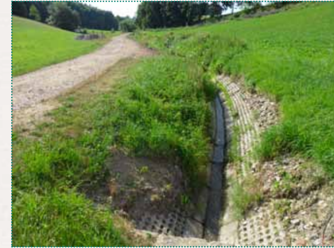
Unterbindung der Durchgängigkeit zwischen Gewässer und Aue durch massiven Verbau von Sohle und Ufer, (Foto: LPV Sächsische Schweiz-Osterzgebirge e.V.)
