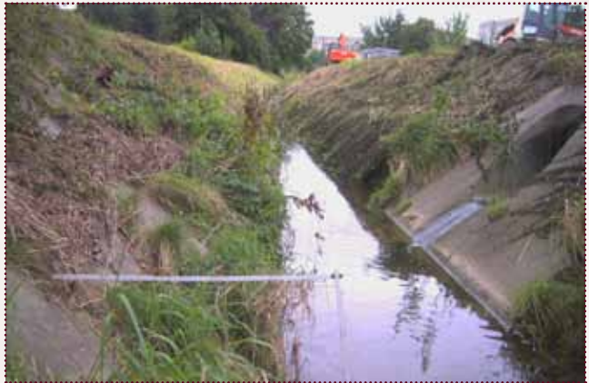
Koitschgraben vor der Maßnahme Quelle: Landeshauptstadt Dresden, Umweltamt
