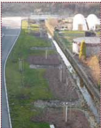
Aufgebrochenes und gestaltetes Süd-Ufer unterhalb der Bahnlinie nach der Renaturierung (Fotos: Landschaftsarchitekturbüro Grohmann Dresden)
